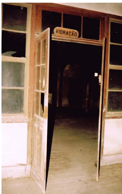
Fig. 05. Secção de “vidração” da Fábrica de Cerâmica das Devesas (fot. de Francisco Queiroz, c. 2002)
